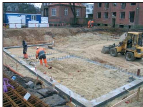
Nederst. Fundamentet støbes. Den 7. februar 2006.
