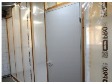
En midlertidig skillevæg blev sat op på et par timer og hindrer støv i at sprede sig.
